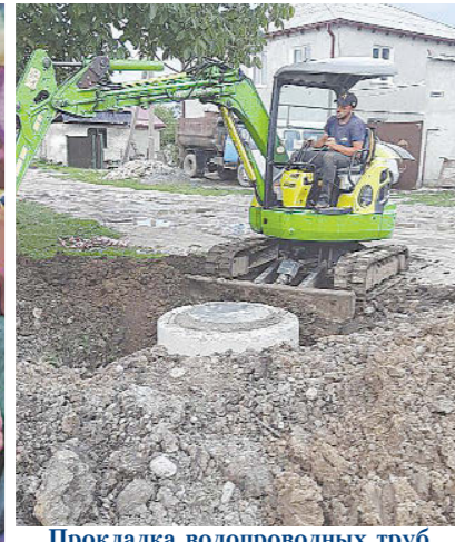
Прокладка водопроводных труб в с. Ир-Восход
