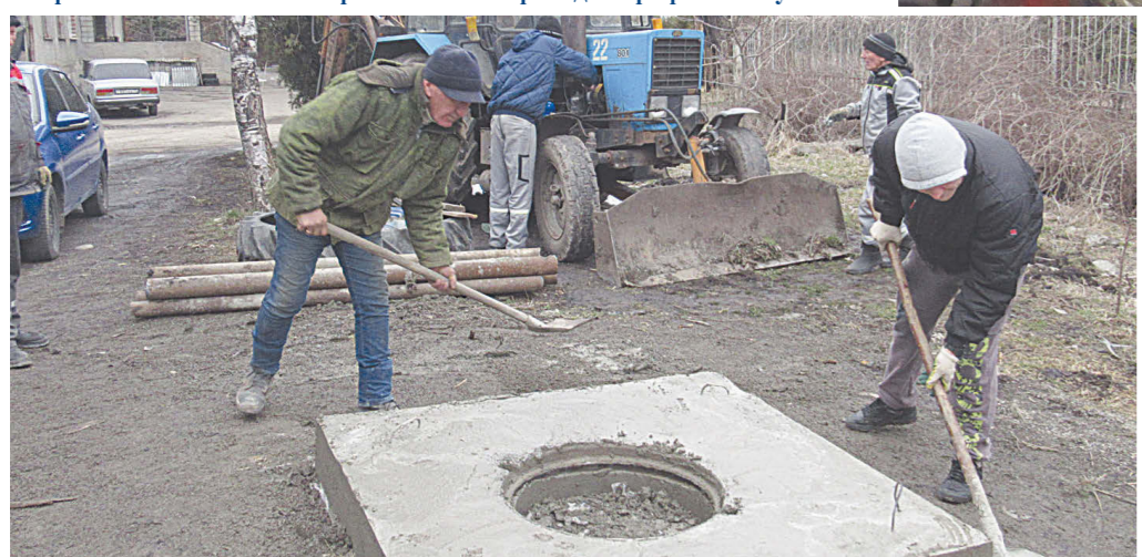
Виталий АВЛОХОВ и Александр АБАЕВ завершили бетонирование крышки колодца
