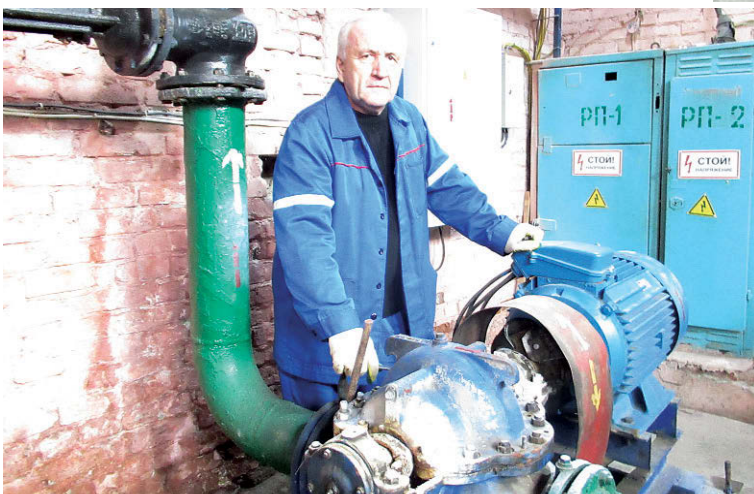
Слесарь Анатолий ГОГИЧАЕВ регулирует работу циркуляционного насоса
