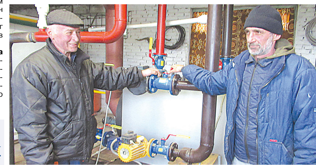
Слесари Валерий ЧЕРТКОЕВ и Алан ЗАНГИБЕВ проверяют узлы котельной установки
