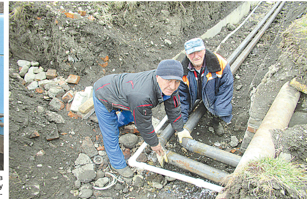
Михайловский участок во время укладки теплотрассы от котельной до СОШ №2 с. Ногир; электросварщик Виталий АВЛОХОВ, слесарь Георгий КАРАЕВ
