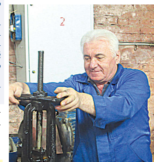
Центральная котельная с. Октябрьского, слесарь Мераб ТУРМАНОВ
