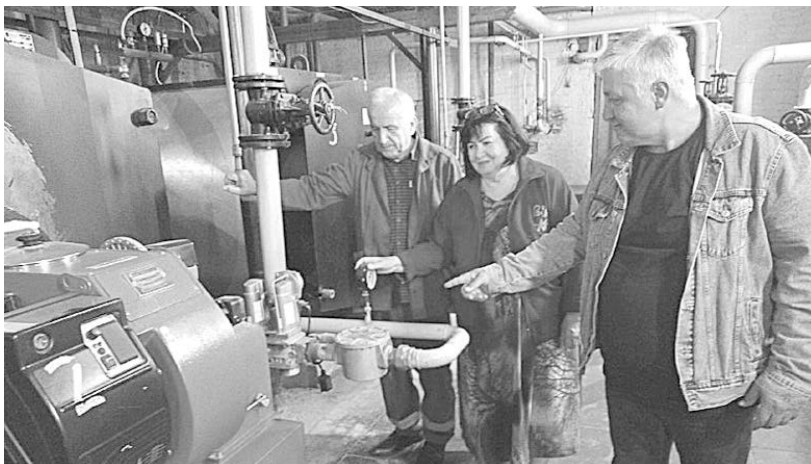
Слева направо: начальник теплоучастка с. Октябрьского Артур ТЕДЕЕВ, оператор Ирина ГАБАРАЕВА, слесарь-сантехник Анатолий ГОГИЧАЕВ при запуске котельной
