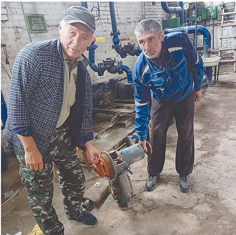
Слесари: Георгий ЧЕРТКОВ и Алан ЗАНГИЕВ демонтировали и установили новый циркуляционный насос
