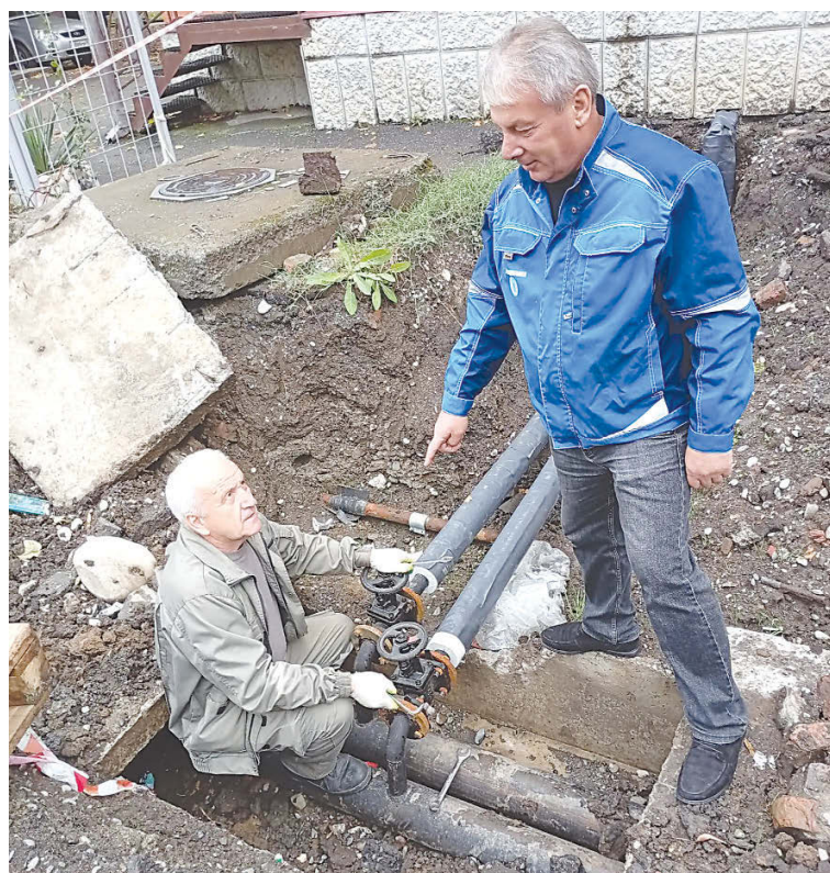
Слева направо: слесарь Анатолий ГОГИЧАЕВ и мастер Октябрьского теплоучастка Казбек АЛБОРОВ устанавливают запорную арматуру на теплотрассе МКД по ул. П. Тедеева 127
