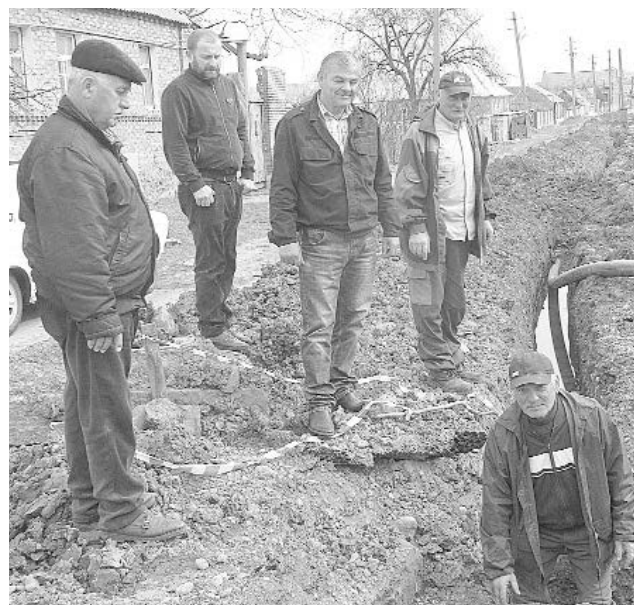
Солтан КОЗАЕВ (начальник участка "водоканал"), Эдуард БАГАЕВ (слесарь), Бибо ГАЗЗАЕВ (водитель), Алик ХУГАЕВ (эксковаторщик), Анатолий БИТИЕВ (слесарь) во время замены водопровода от ул. Хетагурова на переулочек Кооперативный.
